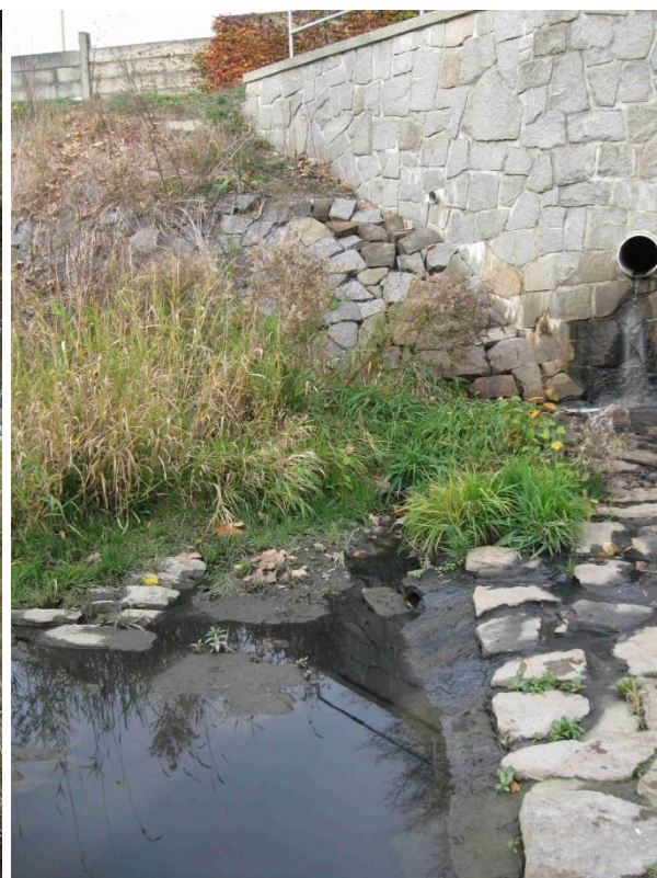
Profil pro nový závěrečný práh, zavázání na pravé straně pod dlažbu na sucho
