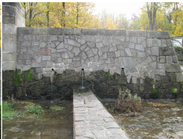
Svislá stěna mezipilíře s doplněným odvodněním
