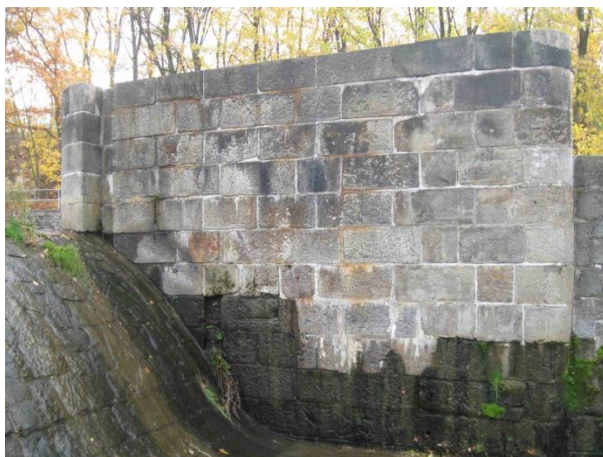
Levý pilíř původního pohyblivého jezu, průsaky
